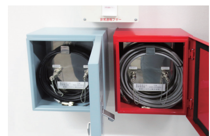
施工例 (屋内露出型 無線機接続端子箱)
